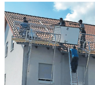
WG ist spezialisiert auf den Einbau von Photovoltaikanlagen FOTO: WG/GRATIS
