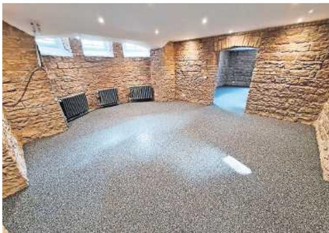
Bema Bauchemie bietet einen Bodenbelag aus einem Guss, ohne Fugen: den sogenannten Steinteppich. FOTO: BEMA BAUCHEMIE/FREI
